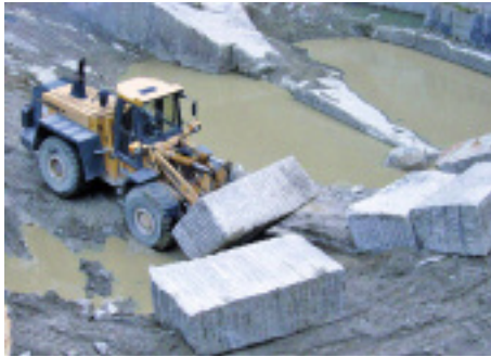
Abtransport von Rohblöcken Foto: Helgert Granit GmbH
