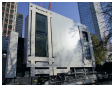
Fassadenschaustücke des vorelementierten Natursteinmoduls Büroturm (links) und der skulpturalen Wohnturmfassade während der Bauzeit
