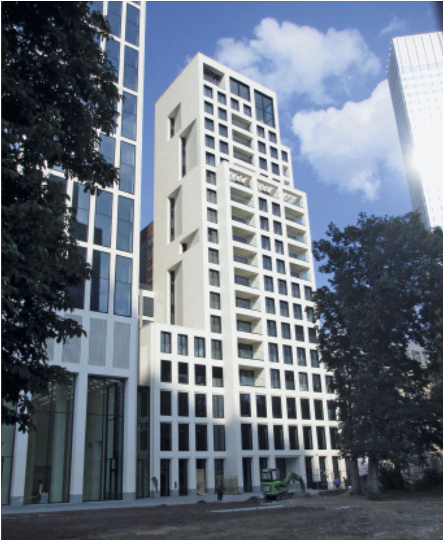
Durch Abstufungen und Rücksprünge gewinnt der Wohnturm an Plastizität. Schräg verlaufende Laibungen verlangten oberste handwerkliche Meisterschaft und verleihen ihm skulpturale Qualität.
